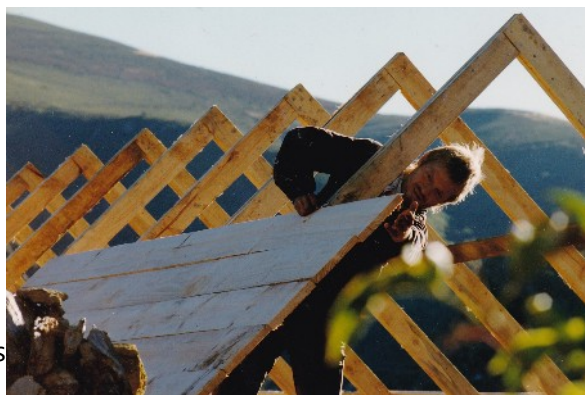
Henning construyendo la primera casa de madera en Matavenero, en 1990 (Foto: Nina Schär)
