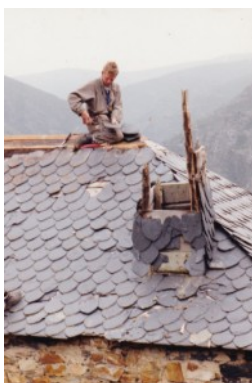
Arreglando el techo de la escuela - marzo 1990
